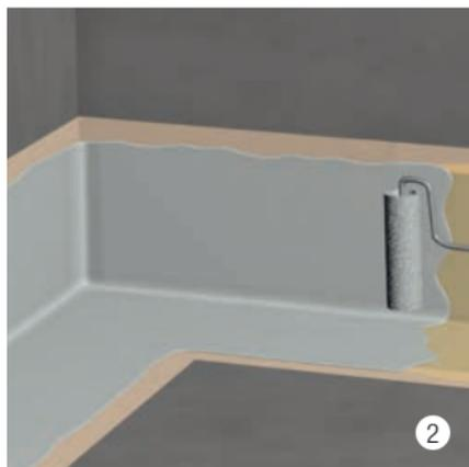
Einbettsschicht mit BIKUCOAT-SMP ECO auftragen (ca. 1,5–2,0 kg/m<sup>2</sup>).
