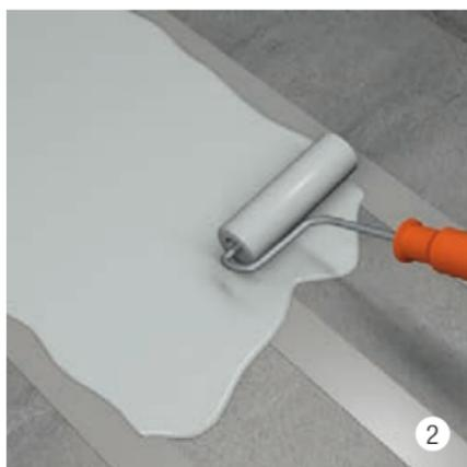
Einbettschicht auftragen mit BIKUCOAT-SMP ECO, Verbrauch ca. 1,5–2,0 kg/m<sup>2</sup>.
