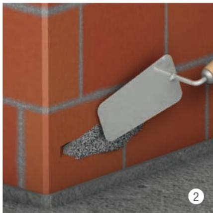
Untergrund gemäss UG-Tabelle S. 10–12 vorbereiten. Bei Bedarf mit BIKUCOAT-Universalprimer 2K grundieren. BIKUCOAT-SMP ECO vorgängig dünn anstreichen, Spachtelmasse auftragen. Alternative: BIKUCOAT-SMP ECO und Weplus 910 Stellmittel
