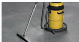
Die Endreinigung muss mittels Staubsauger vorgenommen werden. Schleifstaub in den Poren vermindert die Haftung und ist zwingend zu entfernen.
