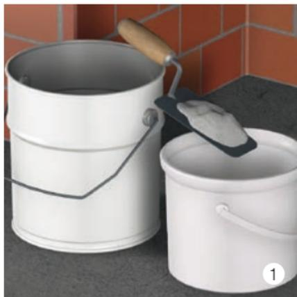
Benötigte Menge Quarzsand (0,1–0,6 mm) in sauberen Mischeimer abfüllen, BIKUCOAT-SMP ECO dazugeben (Mischverh. 1:5), dann mit Rührwerk oder Kelle anrühren.
